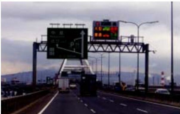
圖 4-12.停車場資訊顯示板及均化控制策略
